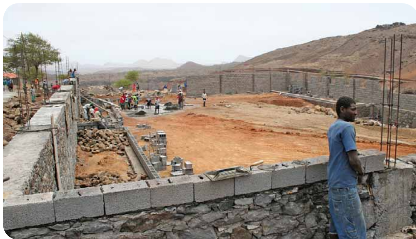
Obras do Polidesportivo de Achada Moirão
