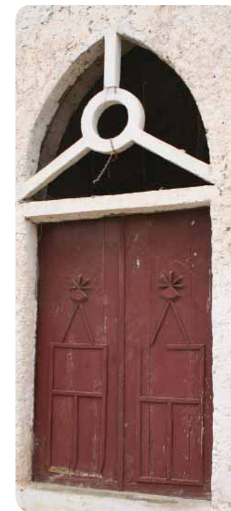
Porta da Igreja de São José, Trás-os-Montes
