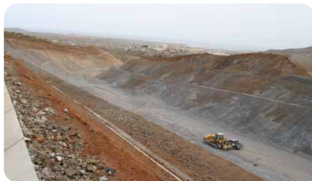
Obras para a Circular da Praia
